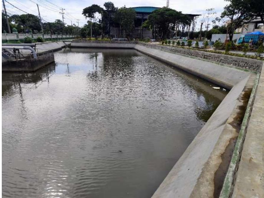
Pembangunan polder depan biro rektor dan taman sekitar polder
