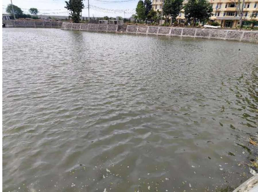
Pembangunan polder belakang (area samping masjid Abu Bakar Assegaf)
